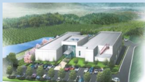
次世代エネルギーシステム研究開発ビレッジ
